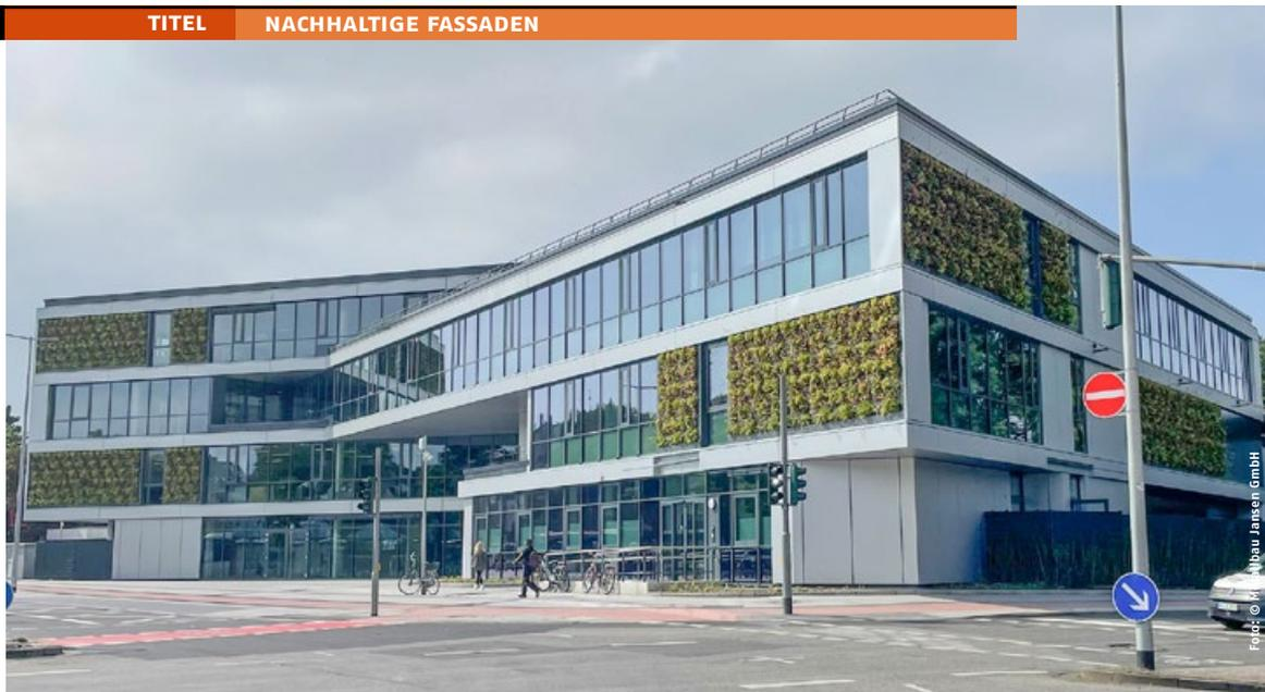
Die hocheffiziente Aluminium-Glasfassade und die vertikalen „Pflanzengärten“ dieses Neubaus in Rheydt wurden von der Metallbau Jansen GmbH gefertigt und montiert.
